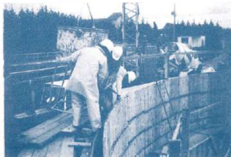
Les ouvriers coulent le béton du silo à boues.
