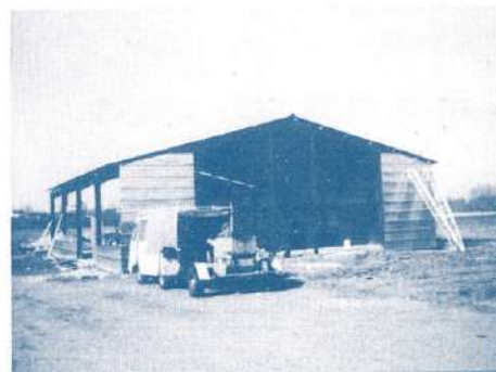
La construction de l'atelier relais.
