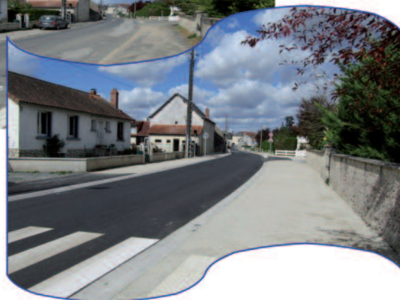
Travaux de voirie Route de Vaux
